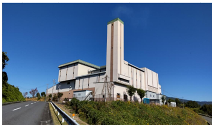
図2-3 中津川市環境センター (外観)
