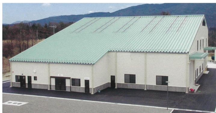
図2-6 中津川市リサイクルセンター (外観)
