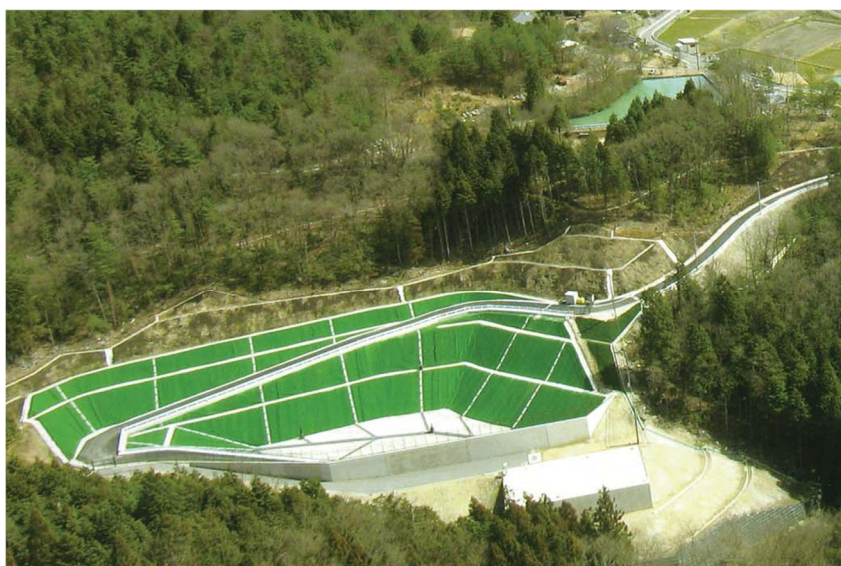
図2-14 恵那市一般廃棄物最終処分場 (外観)
