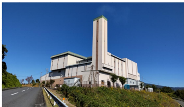
図2-3 中津川市環境センター (外観)
