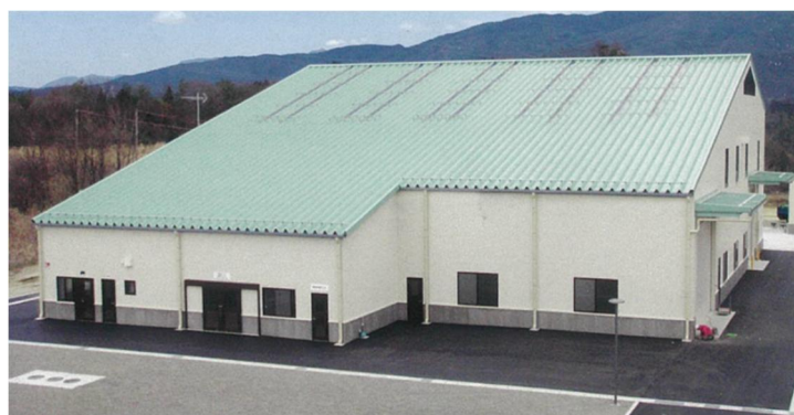
図2-6 中津川市リサイクルセンター (外観)
